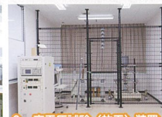
6 高電圧試験(放電)装置
