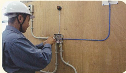
電気工事実習
