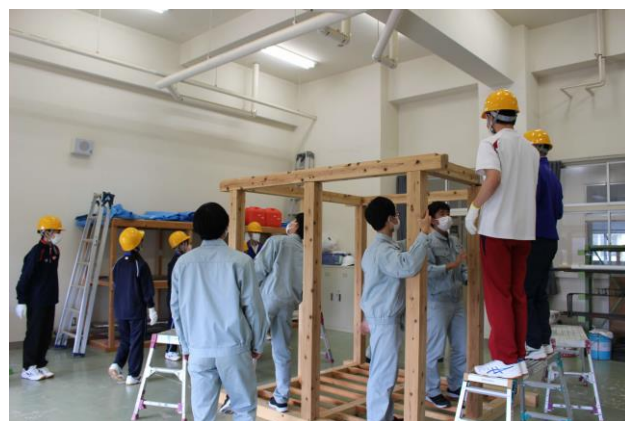
建築科 建方体験
