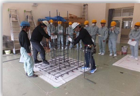
マイスターによる鉄筋組立の実演
