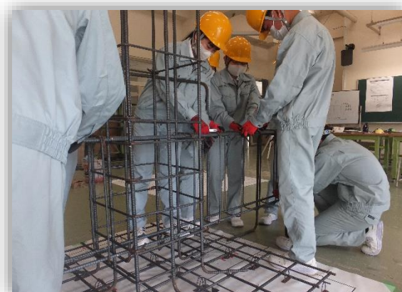
柱・基礎梁の組立の様子
