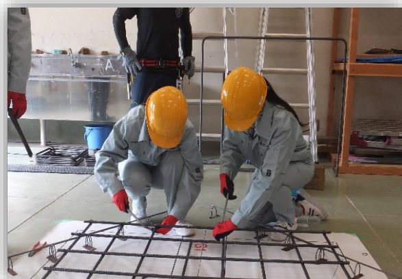
鉄筋の結束練習の様子
