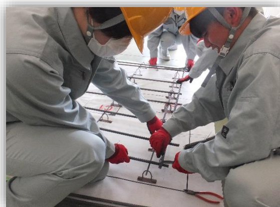
ベース筋の組立の様子
