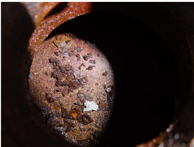
洗浄前のタンク内
