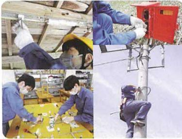
センサーにより自動点灯する照明の取り付けや、校内の蛍光灯をLED照明へ交換しました。
