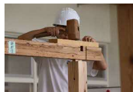
協力して柱や梁を組みました
