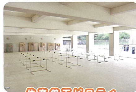
体育館下ピロティ
